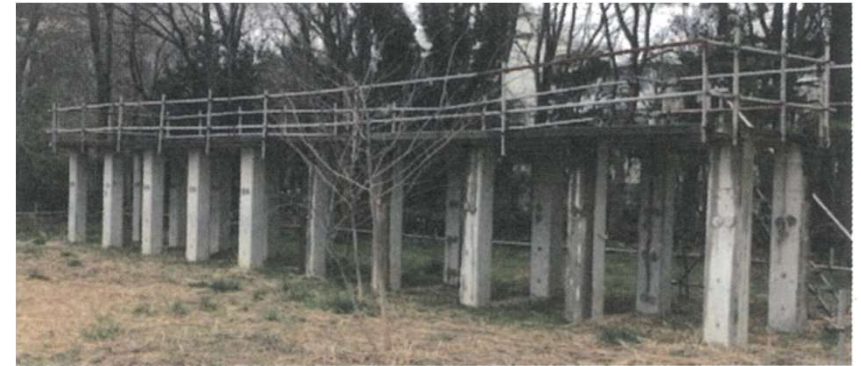
写真1 中規模RCラーメン模擬高架橋 12)
