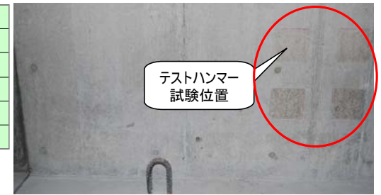
給水養生を実施した大型供試体
